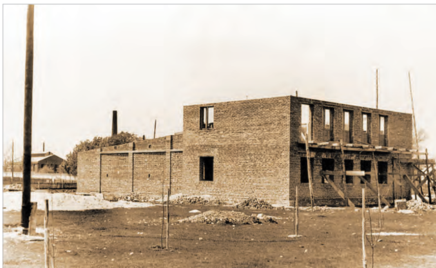
Dubeczno, budowa domu kultury
