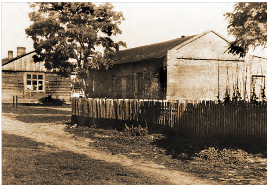
Dubeczno, budynek byłej świetlicy w centrum miejscowości
