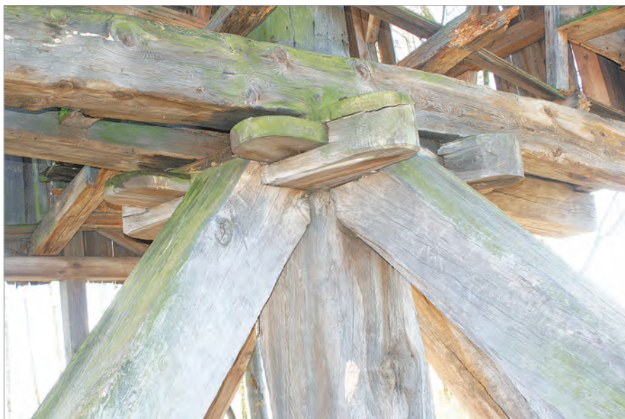
Elementy konstrukcji (tzw. król) wiatraka w Bukowskim Lesie
