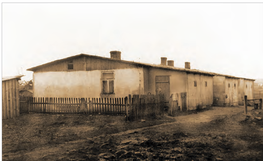
Dubeczno, budynek mieszkalny na torfiankach
